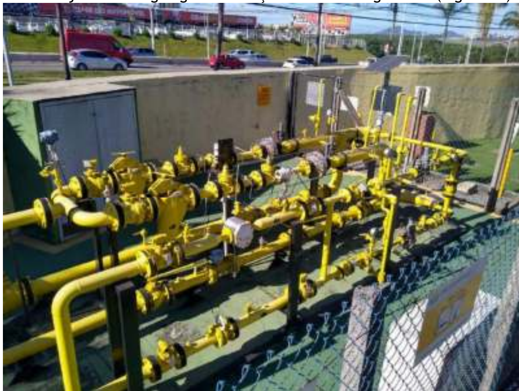
Figura 8 - Exemplo de Estação de Redução Primária
