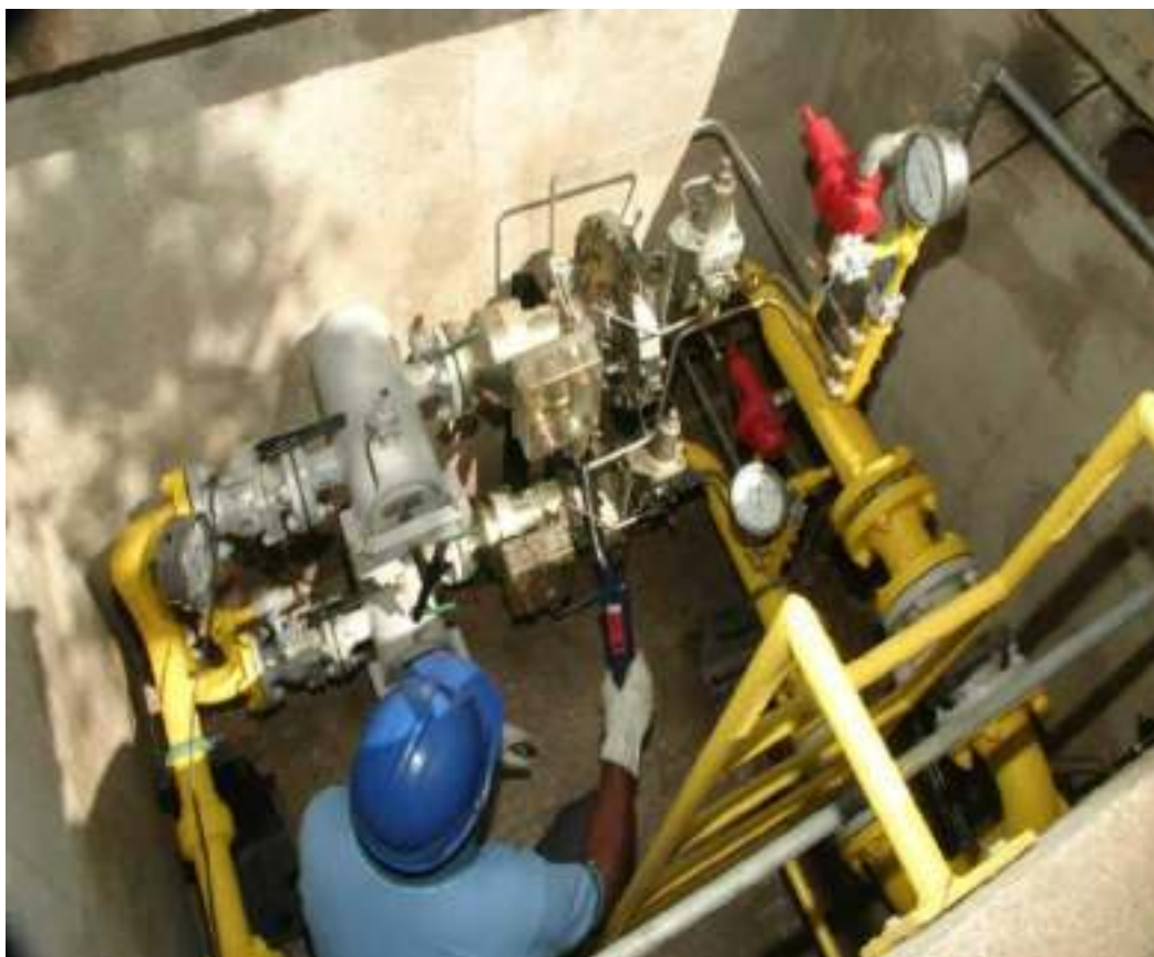
Figura 9 - Exemplo de Estação de Redução Secundária
