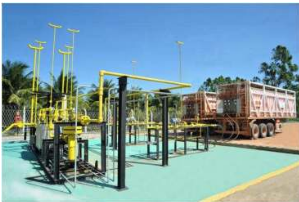
Figura 6 - Estação de Descompressão de Linhares.
