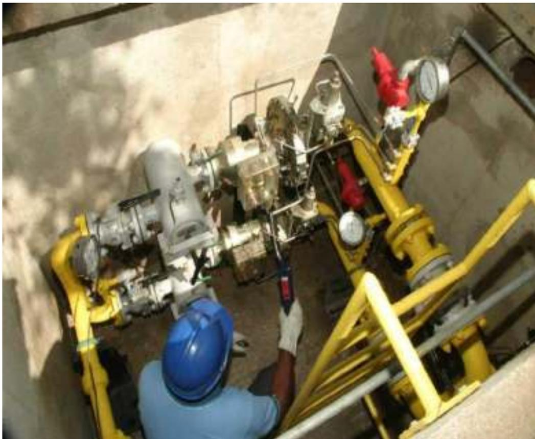
Figura 9 - Exemplo de Estação de Redução Secundária
