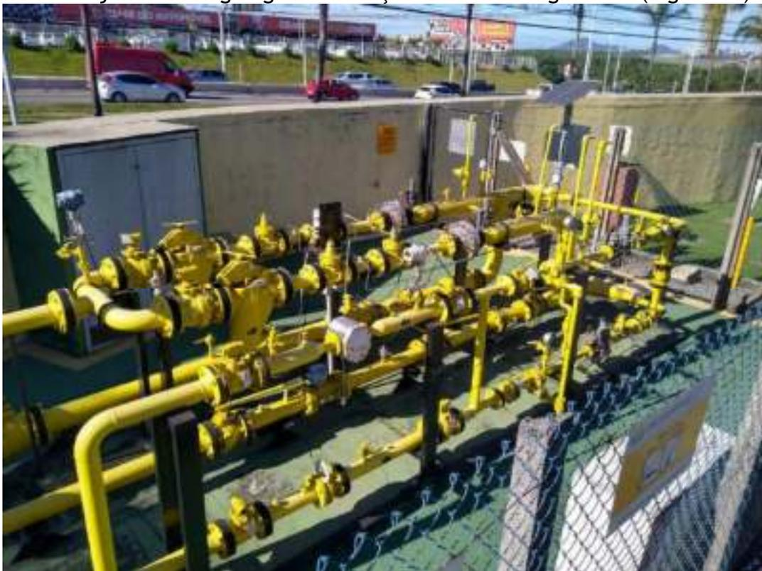
Figura 8 - Exemplo de Estação de Redução Primária
